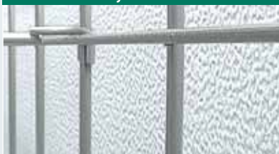
1.) Внутренняя стенка перед началом процесса оттаивания снеговой шубы
